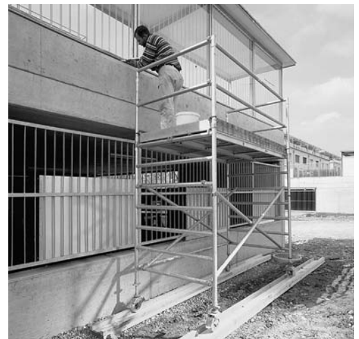
Bild 2: Eine tragfähige Unterlage verhindert ein plötzliches Einsinken der Rollen.
