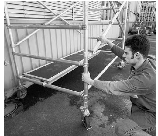
Bild 1: Rollgerüste ohne Mängel sind Voraussetzung für sicheres Arbeiten.
