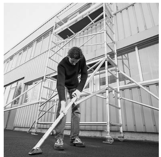
Bild 3: In der Montageanleitung steht, ab welcher Höhe die Abstützungen zu montieren sind.
