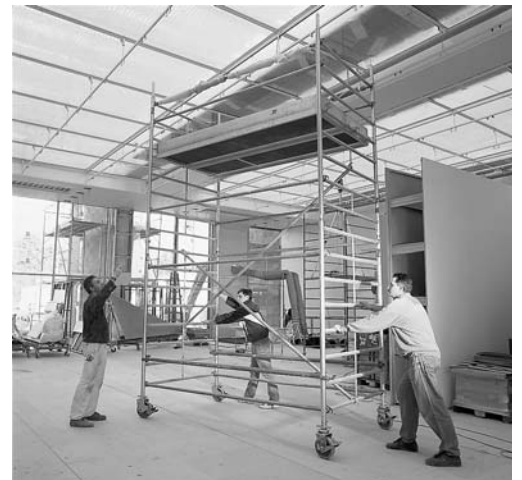
Bild 5: Das Rollgerüst darf nur verschoben werden, wenn sich keine Personen darauf befinden.
