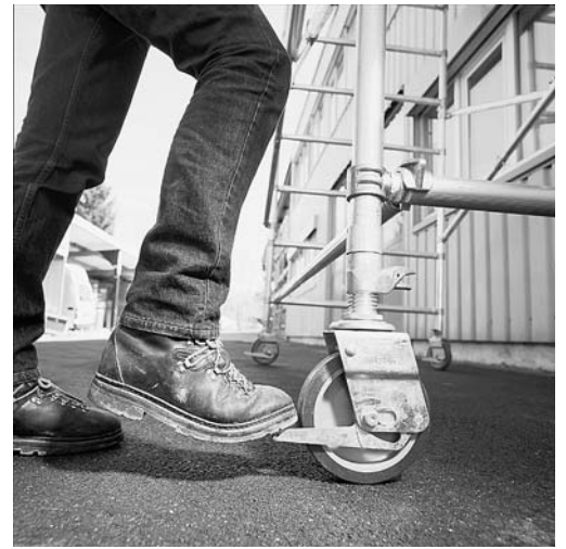
Bild 4: Um ein ungewolltes Wegrollen zu verhindern, müssen die Rollen gesichert sein.
